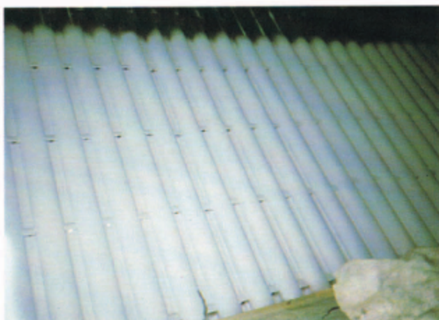
Parede tubular: Protectoloy® 222
